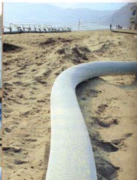
Nella foto in alto: i lavori per la messa in opera del sistema antierosione costiera sulla spiaggia di Allassio. Qui sopra: un tubo di drenaggio prima del suo insabbiamento. A sinistra: Roberto Rossetti della Ge.Co.
