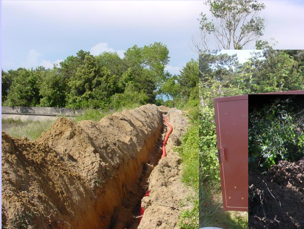
Scavo in trincea collegamento Pompe-quadro elettrico
