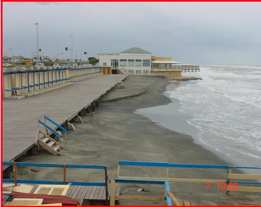
Situazione prima dell'intervento
