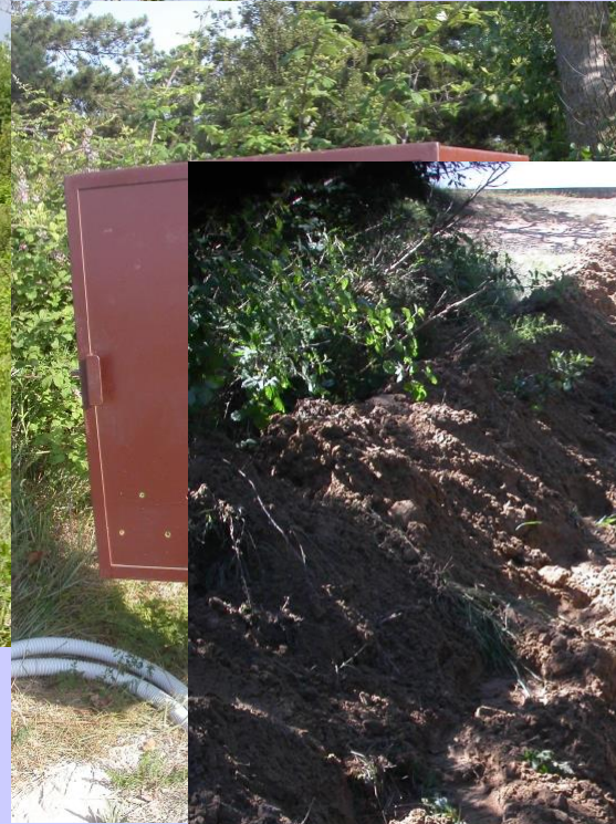
Scavo in trincea collegamento Pompe-quadro elettrico
