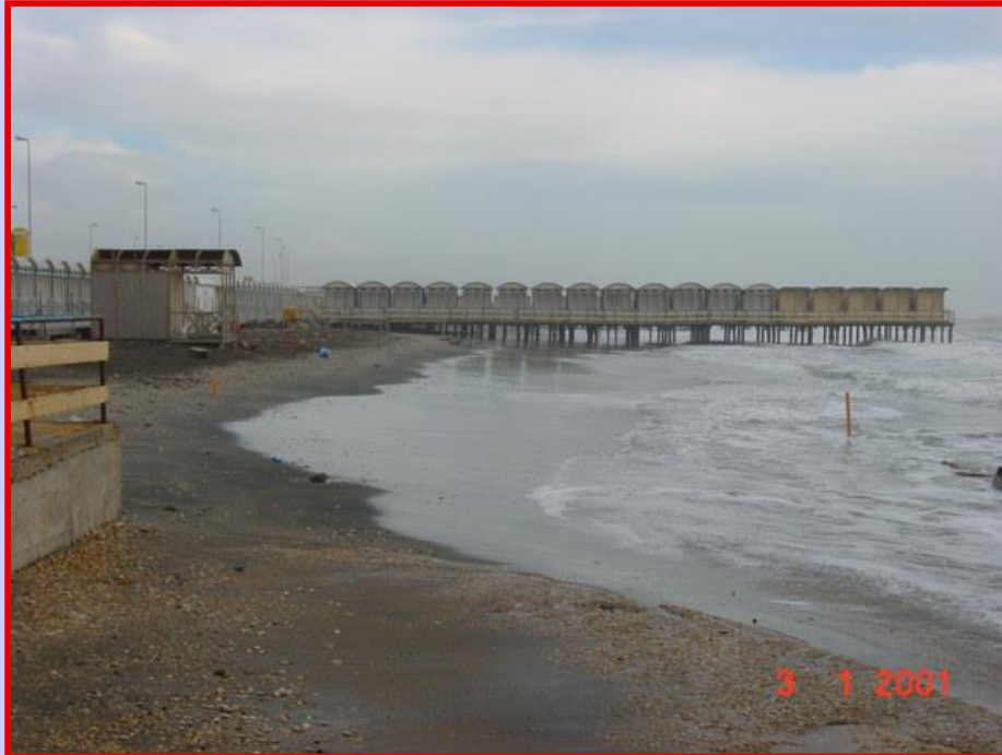
Situazione prima dell'intervento
